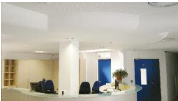
4 Ein Amtsgebäude in Dún Laoghaire wurde im Zuge einer Sanierung mit einer funktionalen Decke im Empfangsbereich ausgestattet.
