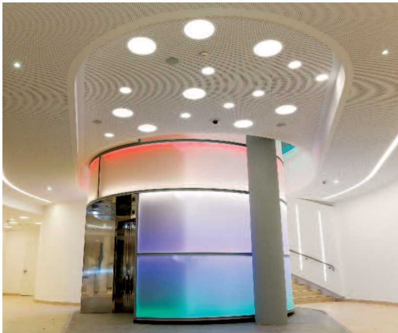
5 Das Unternehmen Lieb Bau Weiz wurde mit den Trockenbauarbeiten in der Bank beauftragt. Die Trockenbauarbeiten an dem Gebäude erstreckten sich über 13 Monate.
