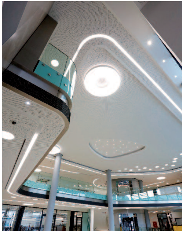
4 Signifikante Merkmale der Akustikdecke: geschwungene Formen und eine perfekte Kantenausbildung.
