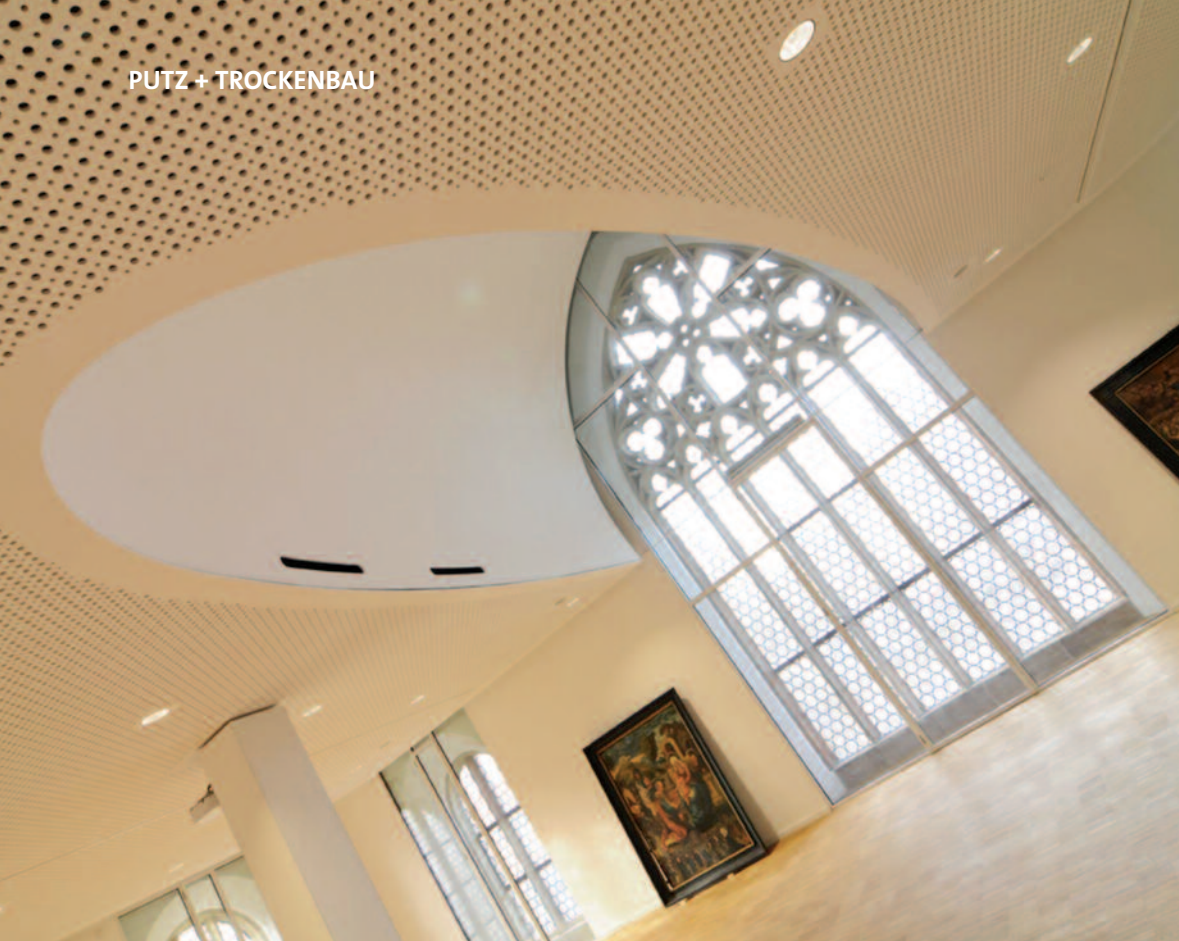
1 Das dreidimensionale Formteil schmiegt sich an das historische Spitzbogenfenster der Nürnberger Sankt Jakobs-Kirche.
