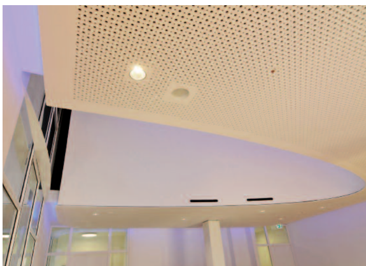
2 Ein Objektberater des Herstellers wirkte von der Konzeption der Muschelkonstruktion bis zur Ausführung mit.
