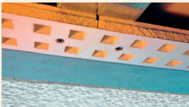
4 Weißer Toptec-Putz mit einer Korngröße bis 0,5 mm.
