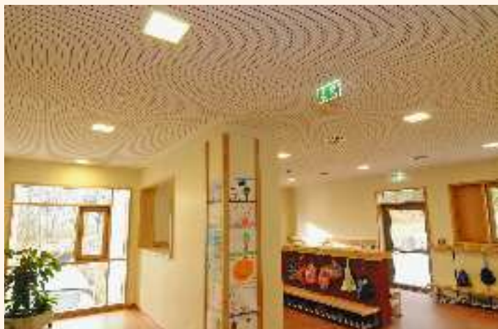
3 Die Decke über dem Garderobenbereich ist eine Akustikdesigndecke mit einem Lochbild 15/30 Rund sowie einem Lochflächenanteil von 19,6 Prozent mit einem schwarzen Akustikvlies.
