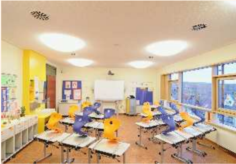
1 Blick in einen Klassenraum. Die Decke ist in Spritzputzcharakter mit Schattenfuge und glattem Randfries ausgeführt.
