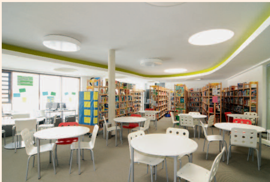
3 Formteile mit präziser Kante und ein spezielles Friestape-Set zur Ausbildung von Friesen halfen den Trockenbauern, das formschöne Design der Decke wirtschaftlich umzusetzen.
