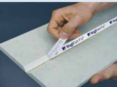
Abdeckfolie vom VogIFalt-Fix-Band entfernen
