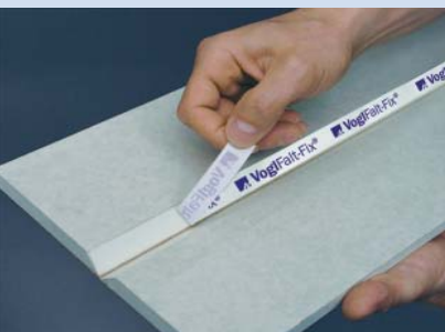
Afdekfolie van VogIFalt-Fix-strip verwijderen
