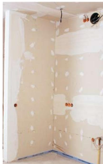
**Arbeitsgang gespart.** Die neue 25 mm dicke Platte reduziert den Arbeitsaufwand überall dort, wo normalerweise eine zweilagige Beplankung mit 12,5 mm dicken Gipsplatten erfolgen muss.
