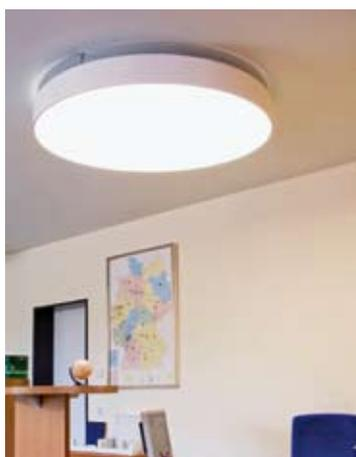
**Angenehm.** Spezielle Leuchtmittel hinter der Folie der Lichtdeckenmodule sorgen für eine gleichmäßige und flächige Ausleuchtung.
