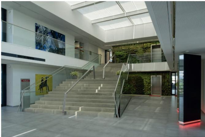
**Bild 2.** Die schallschluckende Decke im Atrium verhilft zu besserer Raumakustik und wirkt den verwendeten schallharten Baumaterialien entgegen
