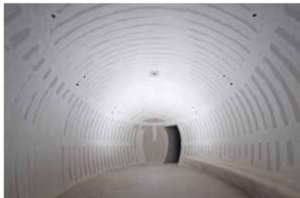
Durch das anschließende Auftragen einer 2 mm Verputzschicht, ließ sich ein homogenes Deckenbild erreichen
