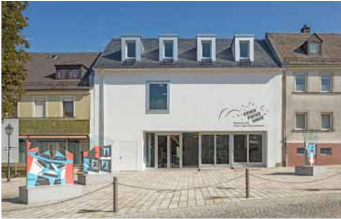
Das Gebäude des Erika-Fuchs-Museums passt sich gut in das Straßenbild von Schwarzenbach/Saale ein
