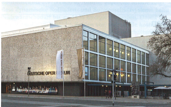
Bild 1. Bei der an sich schon bemerkenswerten heutigen Bauform der Deutschen Oper in Berlin – ein schwebender heller Kubus auf einem dunklen zurückgesetzten Sockel – fällt besonders die dicke Wand aus Waschkiesselputzplatten auf
