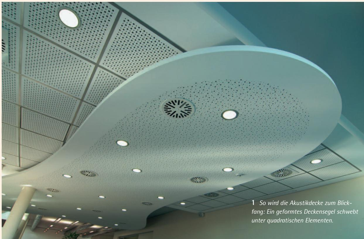
1 So wird die Akustikdecke zum Blickfang: Ein geformtes Deckensegel schwebt unter quadratischen Elementen.
