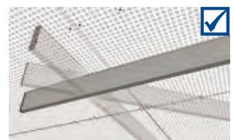
Rückseitige Bedämpfungsauflage direkt auf die Deckenplatten auflegen.
