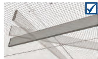
Rückseitige Bedämpfungsauflage direkt auf die Deckenplatten auflegen.
