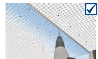
Der aufgelegte Plattenstreifen darf nur einseitig verschraubt werden
