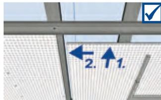
Schrauben am Plattenstoßbereich plattenübergreifend und paarweise verschrauben („Zick-Zack-Prinzip“), links oder rechts neben der bereits gesetzten Fixierschraube beginnen, so entstehen planebene Stoßbereiche
