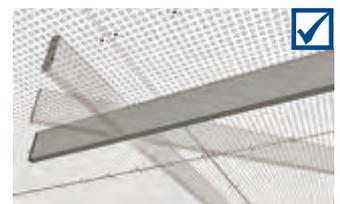
Rückseitige Bedämpfungsauflage direkt auf die Deckenplatten auflegen
