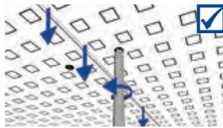
Grundieren der Deckenfläche mit Vogl Supergrund LF, der Untergrund muss frei von Verschmutzungen, trennenden Substanzen und trocken sein. Grundierung unverdünnt mit Lammfellrolle auftragen
