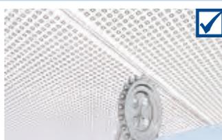
Nach vollständiger Trocknung der Fugenverspachtelung den Bereich mit dem Handschleifer verschleifen
