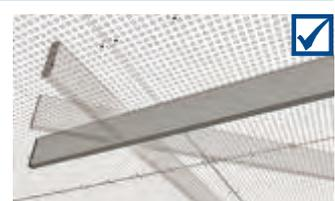
Rückseitige Bedämpfungsauflage direkt auf die Deckenplatten auflegen.
