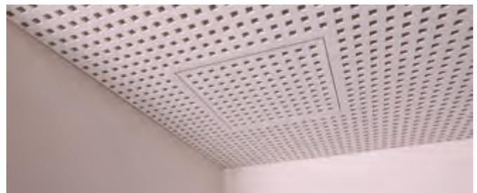
Durch die serienmäßige Fangsicherung (bei Vog|Revisionsklappen > 300 mm) wird ein unbeabsichtigtes Herabfallen des Revisionsklappeneinsatzes beim Öffnen verhindert. Für die Arbeiten im Deckenhohlraum kann der Einsatz dann komfortabel ausgehängt und herausgenommen werden.
