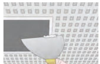
Nach Trocknung des Spachtelmaterials eventuelle Kanten oder Überstände verschleifen.
