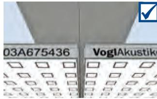
CD-Profil oder Richtscheit als Anschlag nutzen, zur Positionierung nächste Platte am CD-Profil/Richtscheit entlang an erste Platte schieben und fixieren
