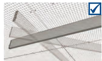
Rückseitige Bedämpfungsauflage direkt auf die Deckenplatten auflegen.
