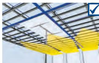
Das Einbringen der Schrauben in die Platte muss rechtwinklig erfolgen und der Schraubensenkopf bis auf 0,5 mm unter die Sichtseite der Deckenplatten eingeschraubt werden
