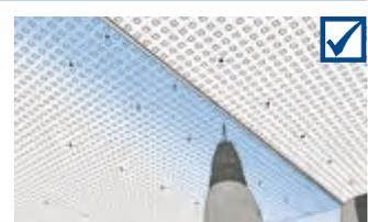
**Wichtig!** Jegliche mechanische Einwirkungen an der Deckenfläche müssen vor Erstellung der Fugen abgeschlossen sein.
